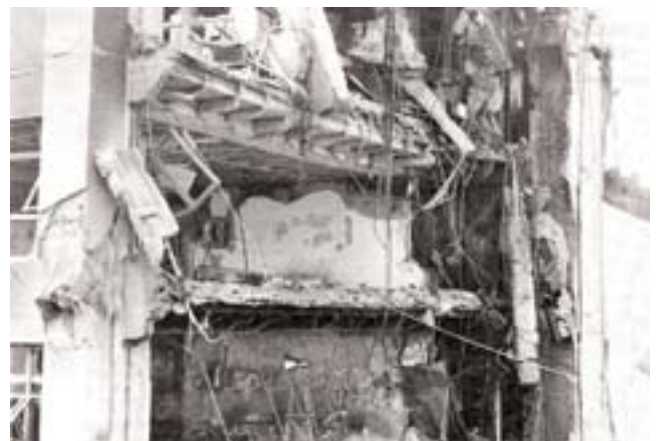
Fig. 7.1. CESP 2 Core Collapse in Sao Paulo, Brazil (Berto and Tomina, 1988)
